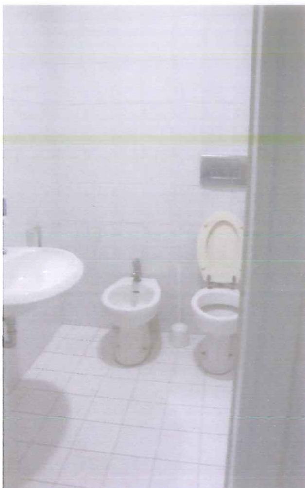
Foto: stato di fatto - disimpegno bagno maschi (terzo piano)
